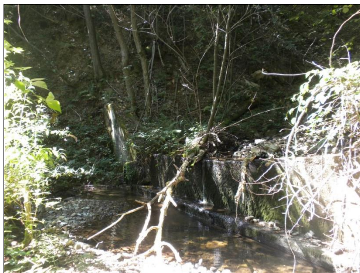
Figura 22: La briglia in calcestruzzo posta trasversalmente all'alveo del Rio Fandaglia all'inizio del tratto canalizzato
