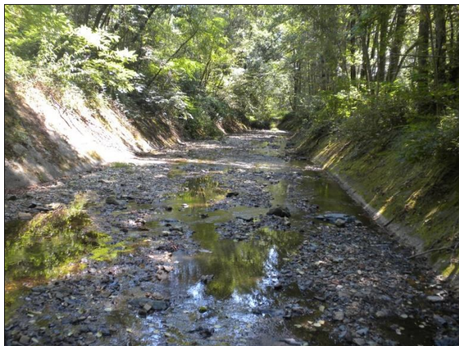
Figura 25b: Altro scorcio del canale artificiale di deviazione delle acque verso il Rio Fornaci – tratto immediatamente a valle della vasca di sedimentazione
