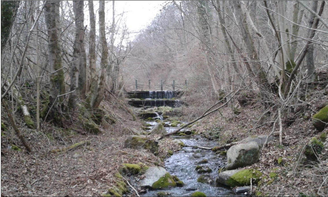
Figura 10: Particolare della sistemazione a salti del fondo a valle della briglia
