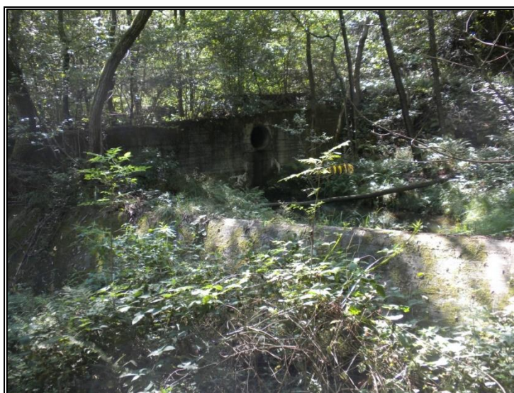
Figura 20: Vista frontale del bacino di sedimentazione posto alla testata del canale artificiale di deviazione delle acque verso il Rio Fornaci.
