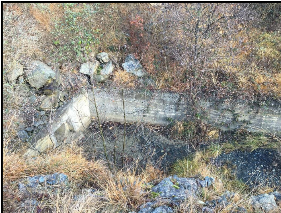
Figura 15: Settore finale dell'impluvio lato Ovest, dove si concentrano le acque drenate dal bacino. In evidenza l'imbocco della tombinatura in c.a.
