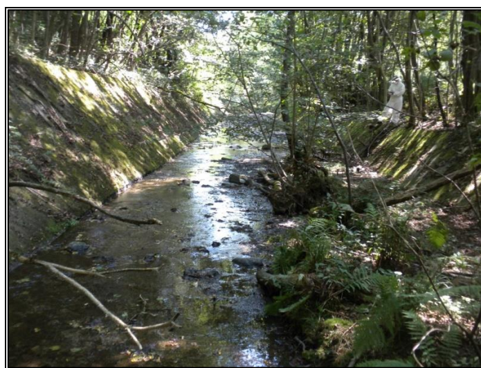
Figura 24a: Il canale artificiale di deviazione delle acque verso il Rio Fornaci
